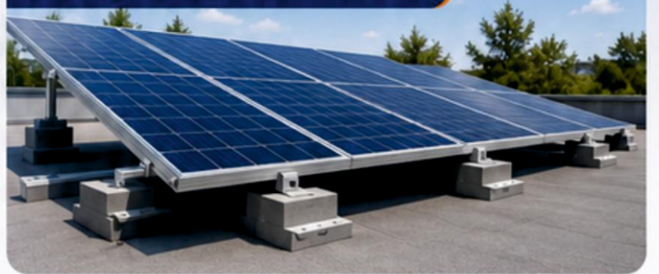
DÜZ ÇATI / ZEMİN MONTAJ UYGULAMASI
